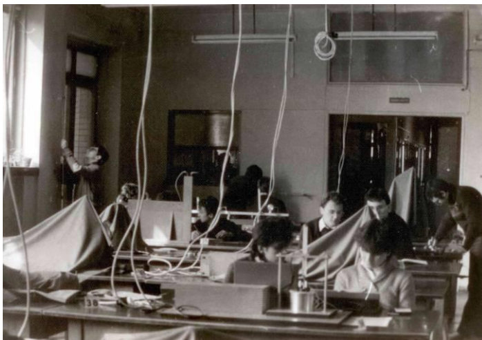
Časť laboratória základného kurzu fyziky v novej budove
