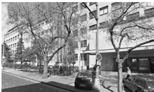
Budova na vtedajšom Gottwaldovom námestí
